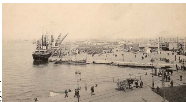
Muelle Reina Victoria. Puerto de Cádiz. Fotografía: AHMC
